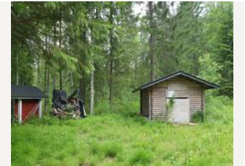
kompostori-wc ja varasto
