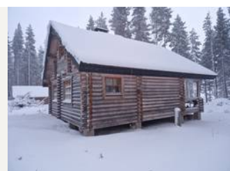
pää- ja varastorakennus lounaasta
