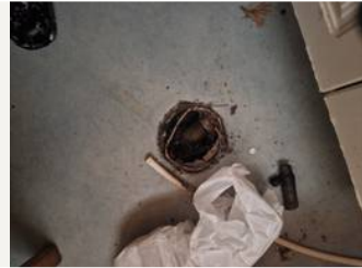
Wv-saunan pukuhuoneen lattiakaivo
