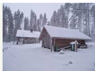
pää- ja varastorakennus koillisesta
