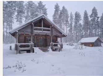
pää- ja varastorakennus kaakosta
