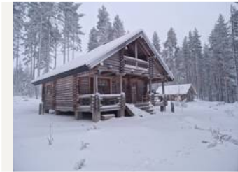
pää- ja varastorakennus etelästä
