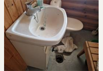
Wc-saunan pukuhuone lattiakaivo
