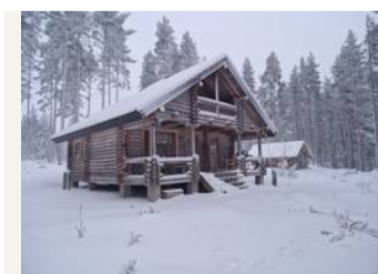
pää- ja varastorakennus etelästä
