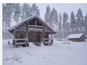
pää- ja varastorakennus kaakosta
