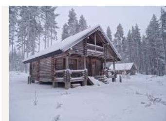
pää- ja varastorakennus etelästä
