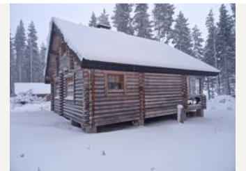
pää- ja varastorakennus lounaasta
