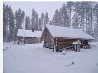
pää- ja varastorakennus koillisesta
